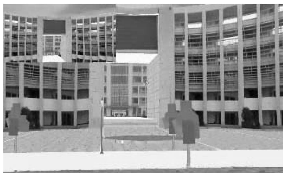
图 4 采用纹理映射技术的楼体 2
